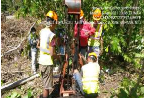
Gambar 2. Dokumentasi Hasil Uji Sondir Titik 1
