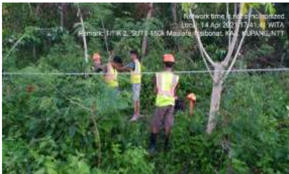
Gambar 5. Dokumentasi Hasil Uji Sondir Titik 2
