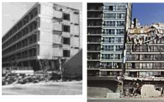
(a) Runtuhnya Tower Tangga Rumah Sakit Olive View, gempa San Fenando 1971 (b) Runtuhnya lantai atas Hotel Mexico City's, gempa Meksiko 1985
