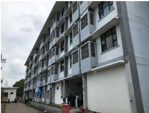
Gambar 10. Motor parkir di luar bangunan dikarenakan keterbatasan ruang parkir dalam kawasan rumah susun Siwalankerto
