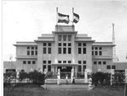
Figure 17. Jaarbeursgebouw. Bandung, 1919, Wolff Schoemaker Source: (lostandwander1976 2017)
